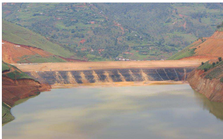
Bassin (lac artificiel) pour le rejet des effluents
